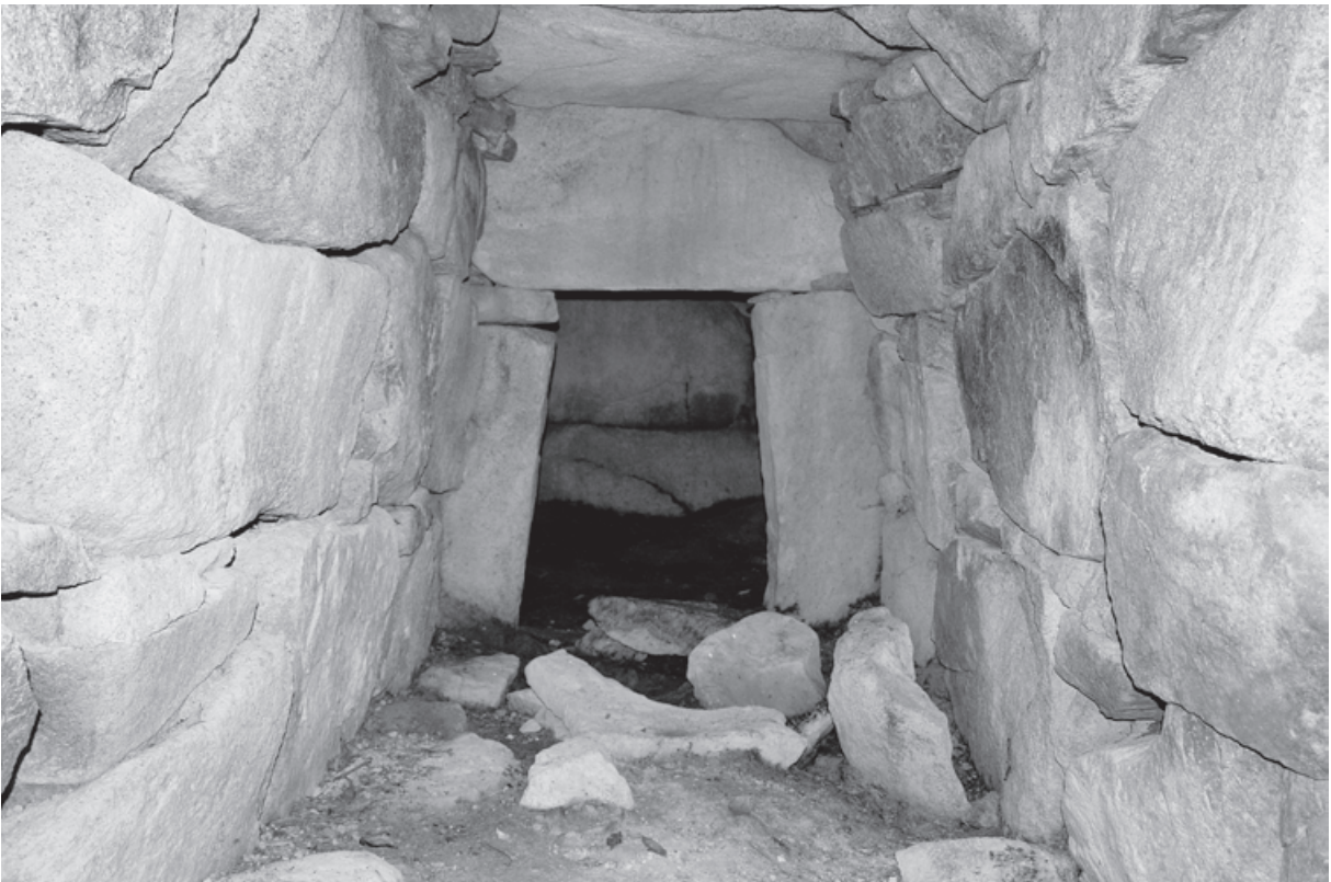
塚山古墳群Ⅱc支群 Ⅱ-12号墳石室
