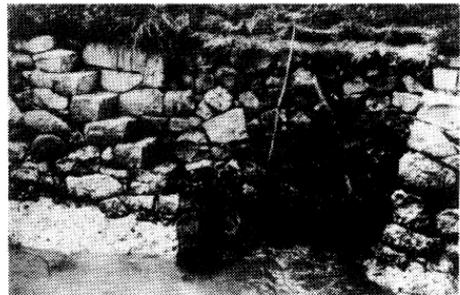
この「浜溝」の効用は、溝の海水が地盤にシタシオ（下潮）となつて浸透し、適度の毛細管現象によつて海水が地盤表面に上昇していき、撒潮労働を節約できることであつた。また溶出のための海水を手近で汲み取ることができるといふ効用もあつた。
