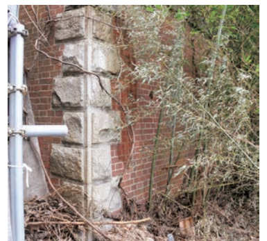
旧有年橋橋台
