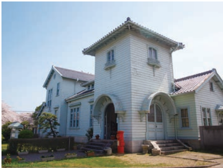
旧日本専売公社赤穂支局 兵庫県指定建造物。現在は赤穂市立民俗資料館となっている。
