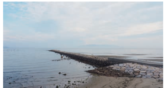
百間波止 海水の取水口でもある水尾に千種川の運ぶ土砂が入らないように築かれた。
