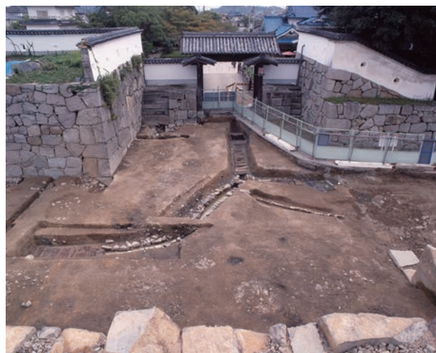
三之丸大手門枅形 赤穂城の玄関口。改変される前の石垣 や旧上水道が見つかった。
