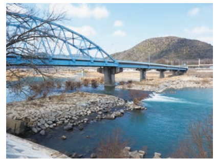
根木鉄橋基礎跡
