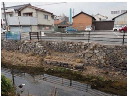
加里屋川護岸の雁木
