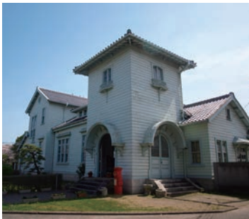
旧日本専売公社赤穂支局 明治 41（1908）年に建築された建築で、現在は民俗資料館となっている。
