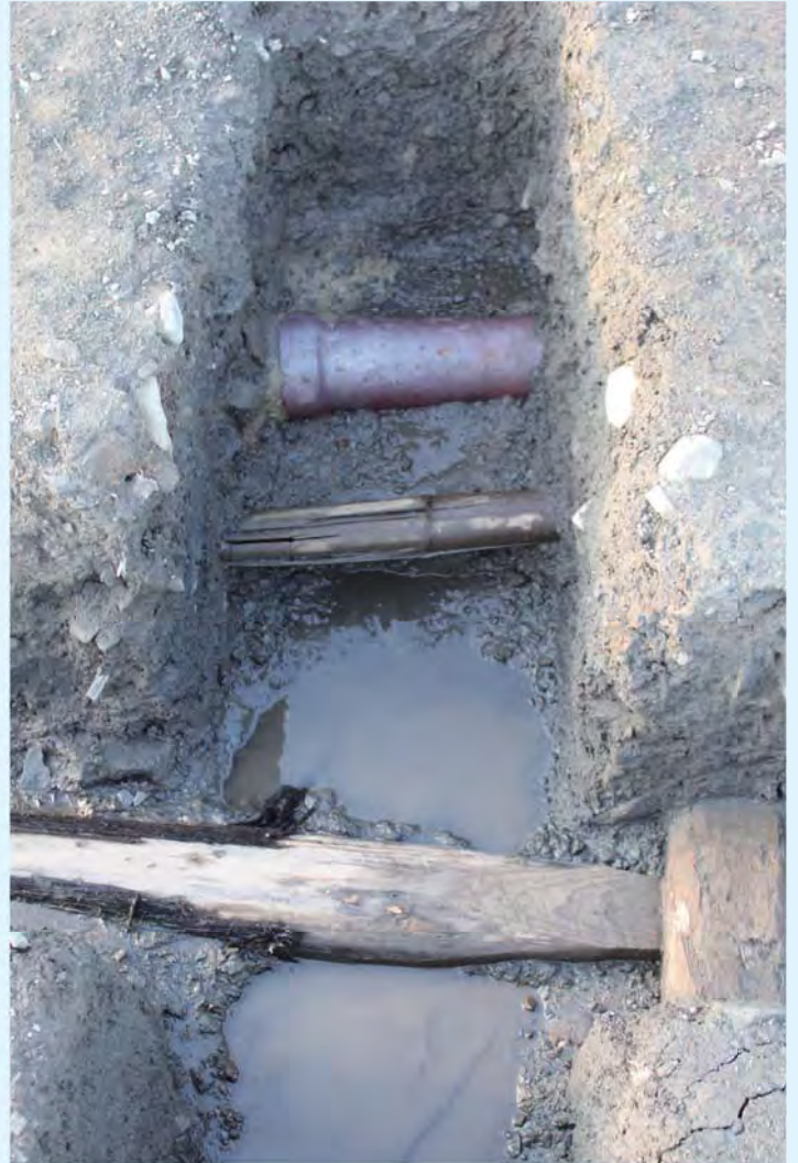
▲3種類の水道管 何度も改修を重ねたことがわかります。
