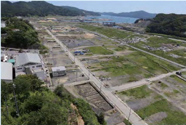
▲調査地 空地の部分は震災時の津波による被害を受けた場所です。
