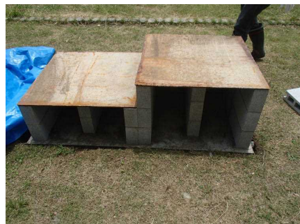
完成したピザ窯の土台
