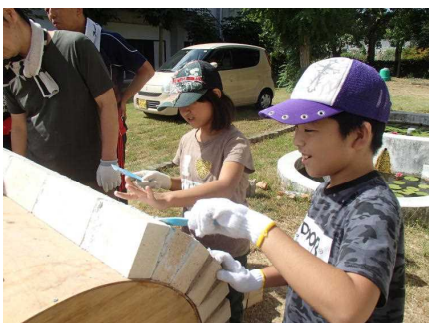
A-1千型の木枠にレンガをのせます
