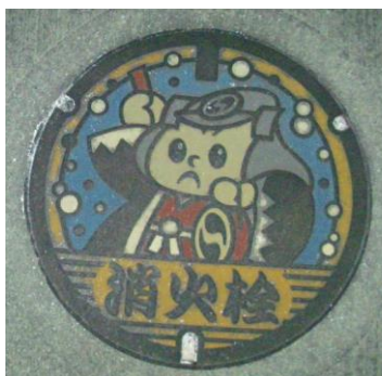
しょう か せん 消 火 栓
