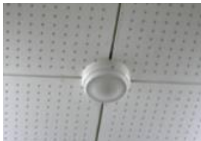
ねつかん ち き 熱 感 知 器 (おん ど さ はんのう 温度差で反応する)
