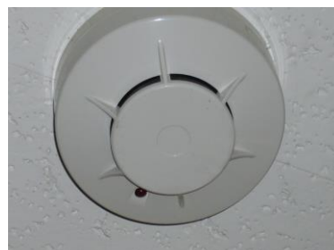
けむり かん ち き けむり 感 知 器 (けむりが入ると反応する)
