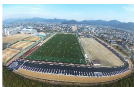
平成27年(2015)赤穂海浜スポーツセンター完成
