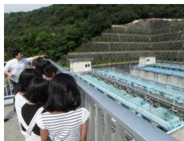
配水池の様子(4年)
